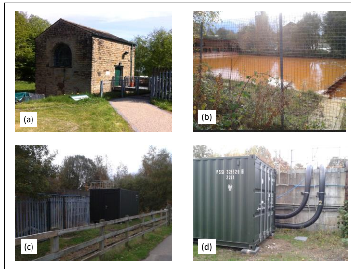
Figure 6.21: ( a) Inman shaft building. (b) Mine water treatment pond. (d) GSHP system container. (d) Main mine water discharge header pipes
