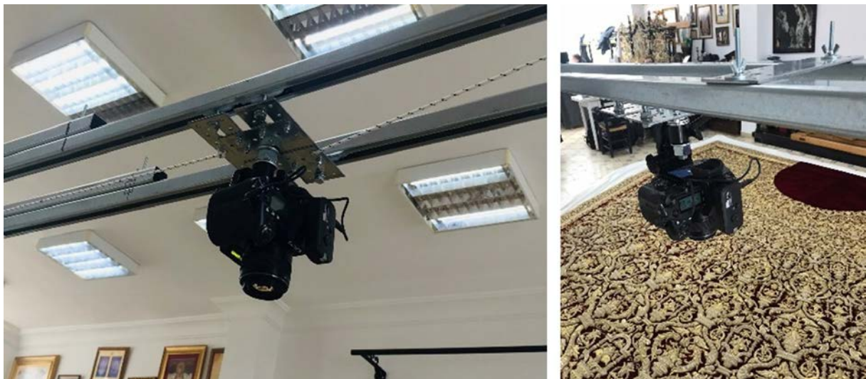
Fig. 1. Estructura auxiliar para desplazamiento de la cámara.
