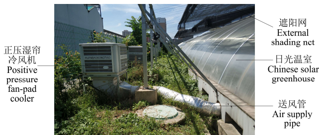
图 1 正压湿帘冷风降温系统实物图
