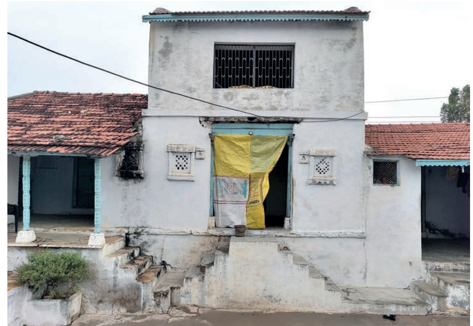
४६. एक मंजिला आवास-१ में निर्माण की गई नई उपरी मंजिल।
